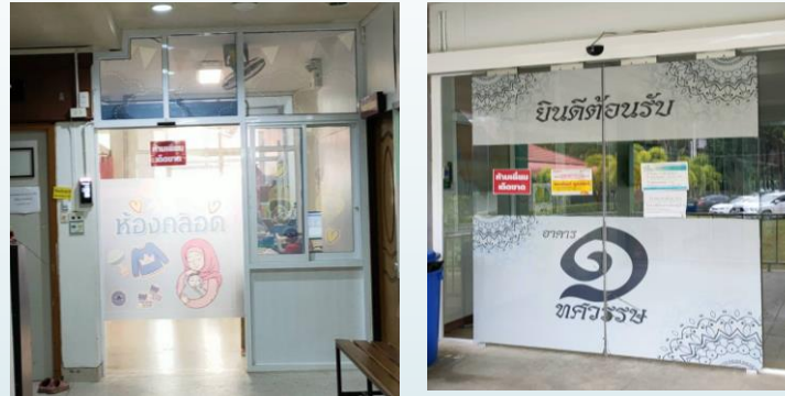
ระบบประตูเปิด - ปิด อัตโนมัติ ในอาคาร
