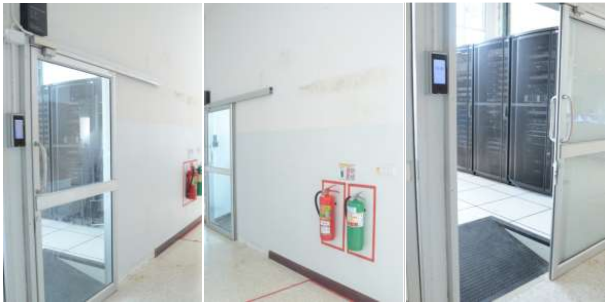
ด้านหน้า ห้อง Data Center (Server Room)
