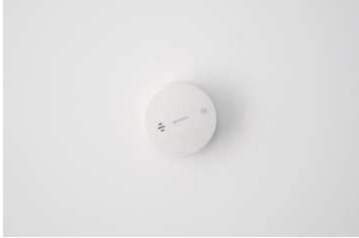
ระบบวัดอุณหภูมิและความชื้น
