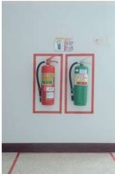
ระบบดับเพลิง
